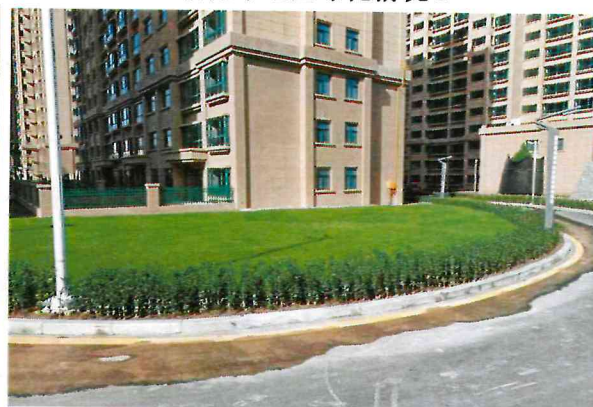
道路及配套设施区绿化情况 2
