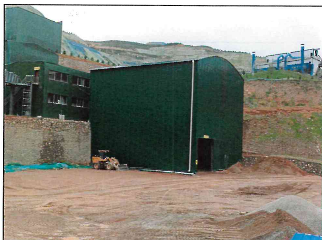
全封闭式除土车间
