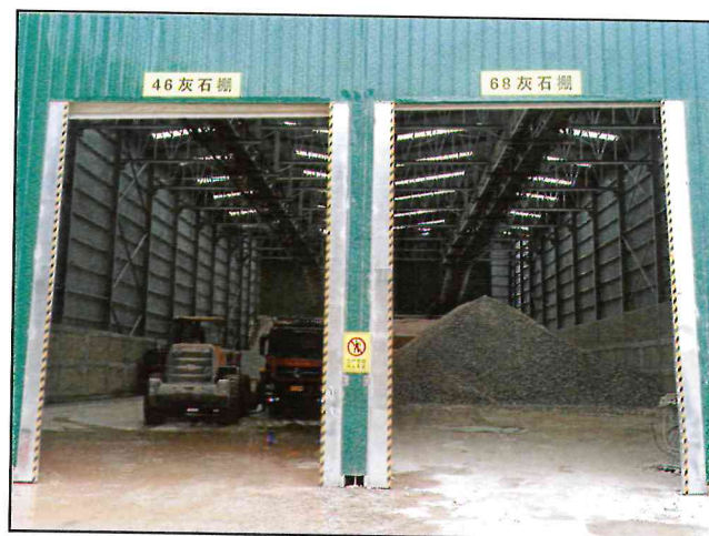
全封闭式产品堆棚
