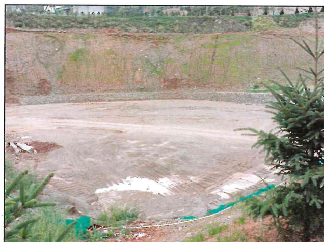
排土场（暂未启用）
