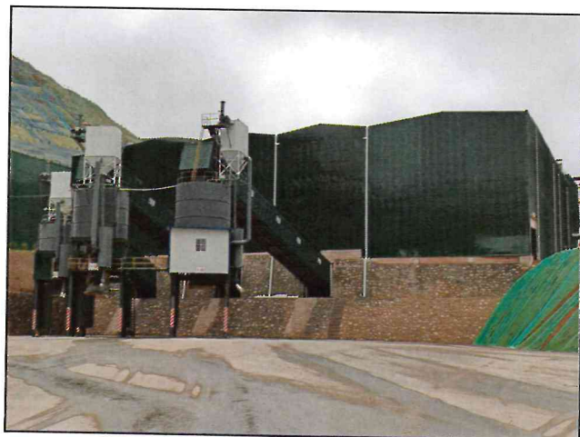
全封闭式产品堆棚及装车筒仓
